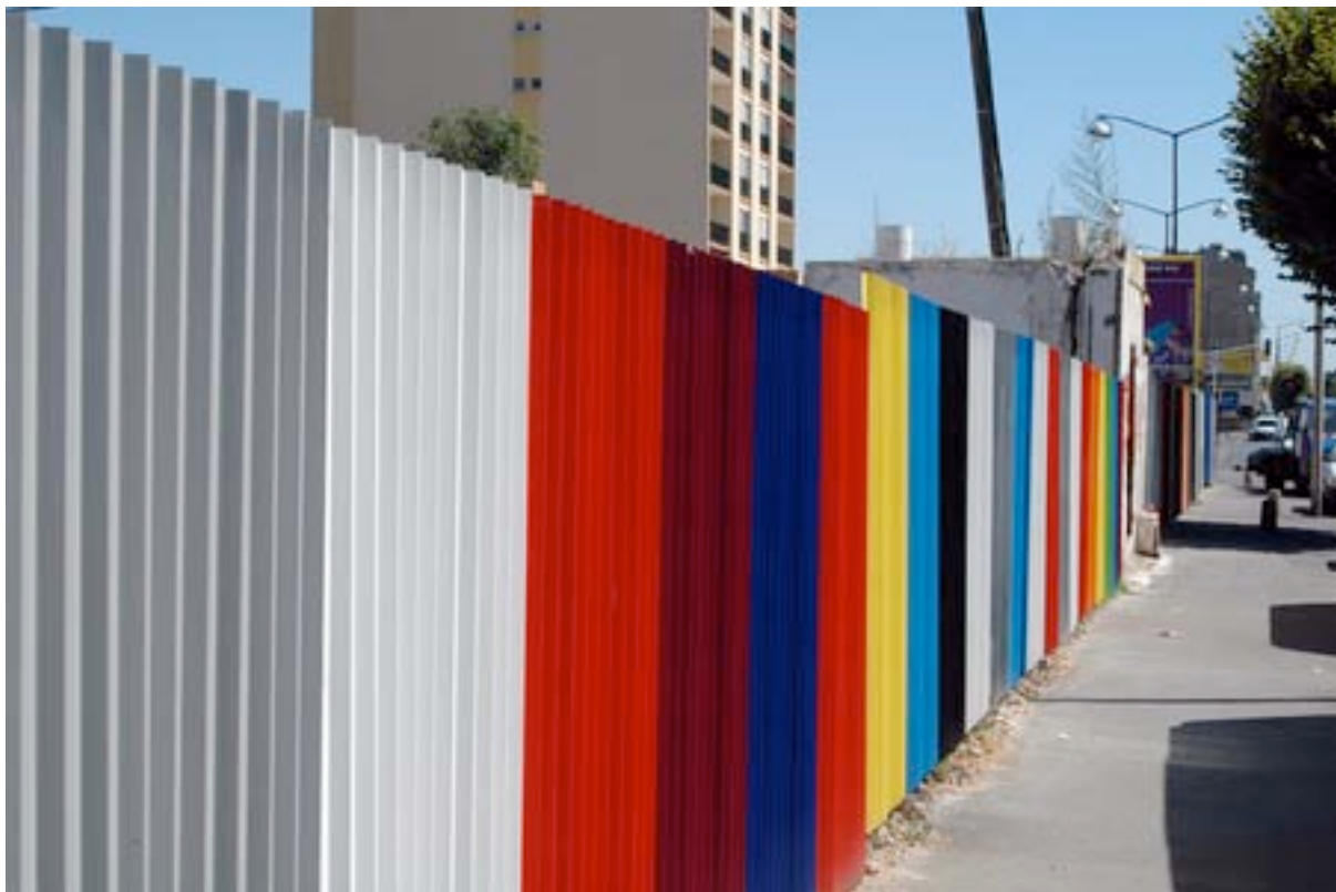
Figure 12: palissade MUR-RAL le long de l'avenue de Verdun (ex RN305). Source: www.trans305.org
