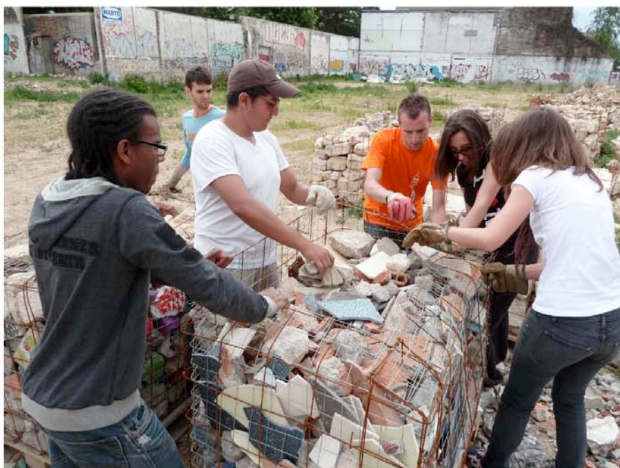
travail de chantier / Atelier/TRANS305 - juin 2010 - P1000233.JPG
