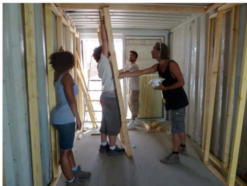
chantier de montage - juillet 2010 - P1010466.JPG
