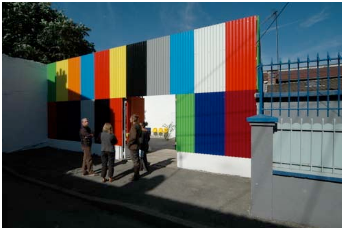
Figure 18: l'atelier du passage Hoche terminé.
